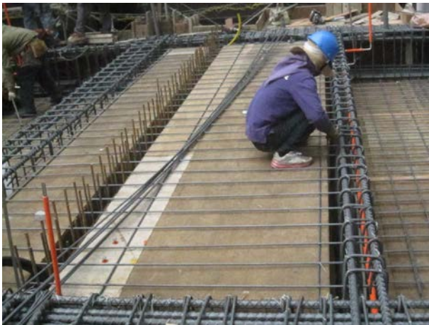
說明 15：版筋施工
