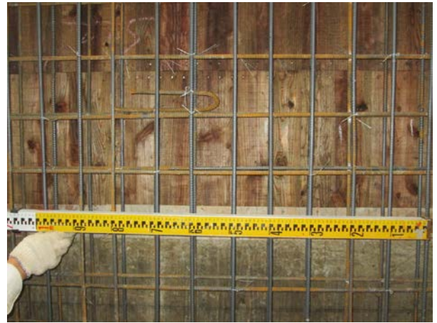
說明 20：牆鋼筋間距查驗
