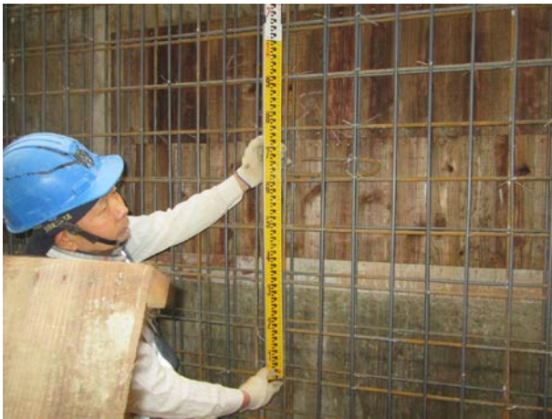
說明 21：牆鋼筋間距查驗
