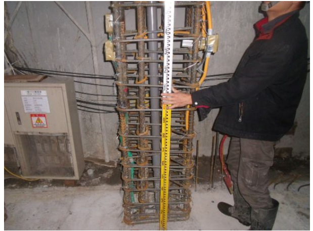
說明 8：柱鋼筋組立檢查
