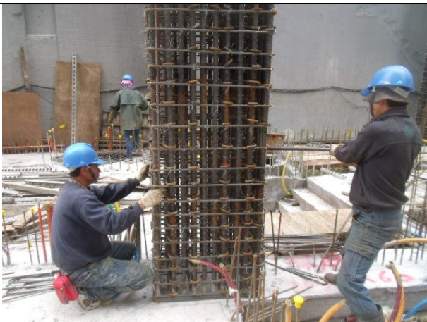
說明 5：柱鋼筋組立
