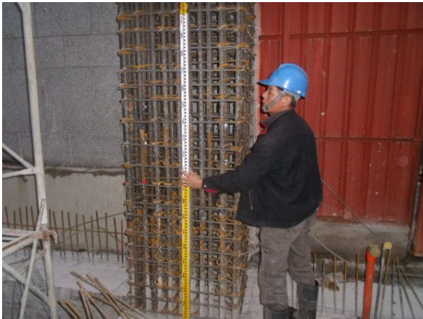
說明 9：柱鋼筋組立完成
