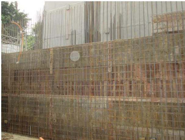
說明 15：牆鋼筋組立完成
