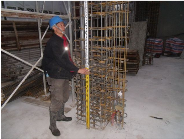
說明 7：柱鋼筋組立檢查
