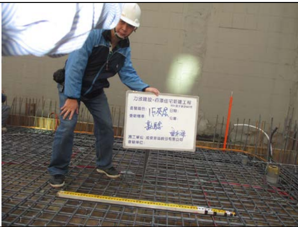
說明 29：建築師施工查驗
