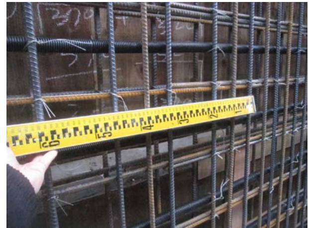
說明 22：牆鋼筋間距查驗
