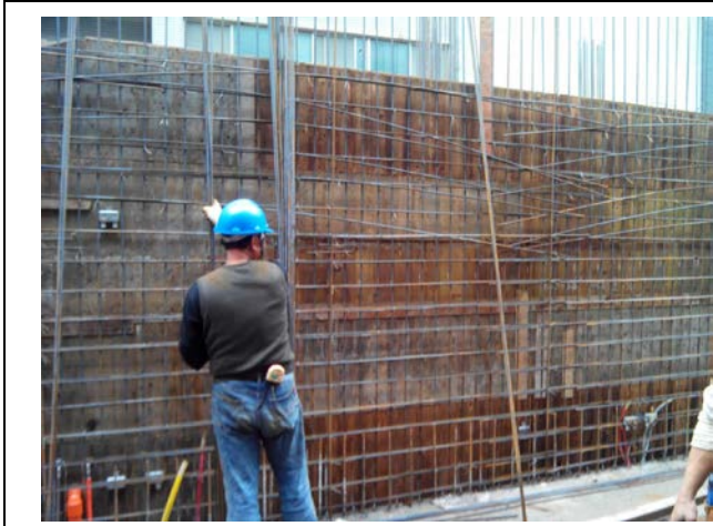
說明 13：牆鋼筋組立
