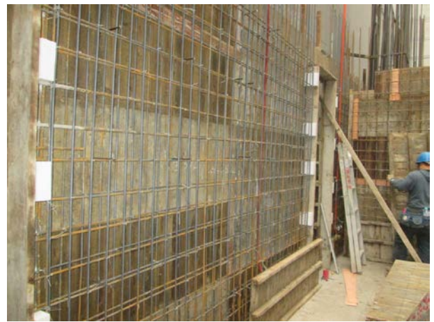
說明 14：牆鋼筋組立完成
