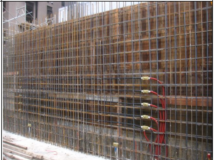
說明 16：牆鋼筋組立完成
