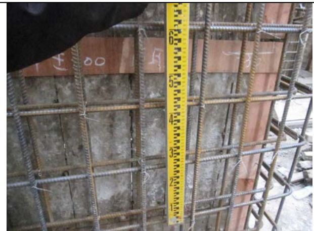
說明 24：牆鋼筋間距查驗
