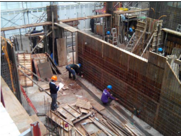
說明 11：牆鋼筋組立
