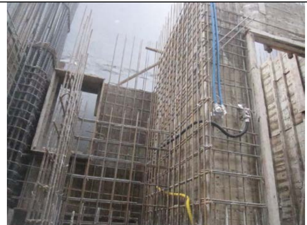
說明 18：牆鋼筋組立完成
