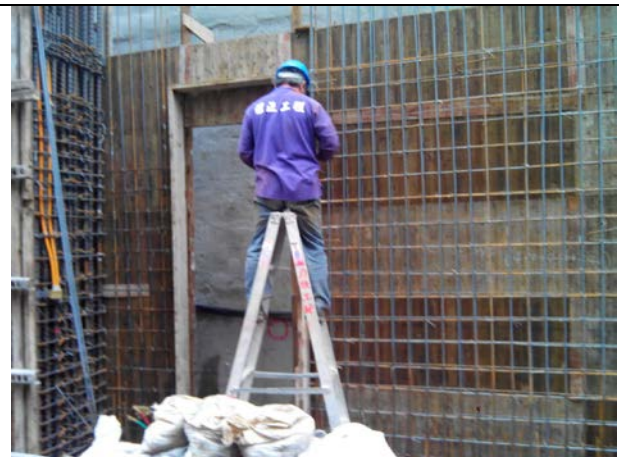
說明 12：牆鋼筋組立
