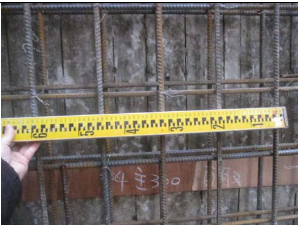
說明 23：牆鋼筋間距查驗
