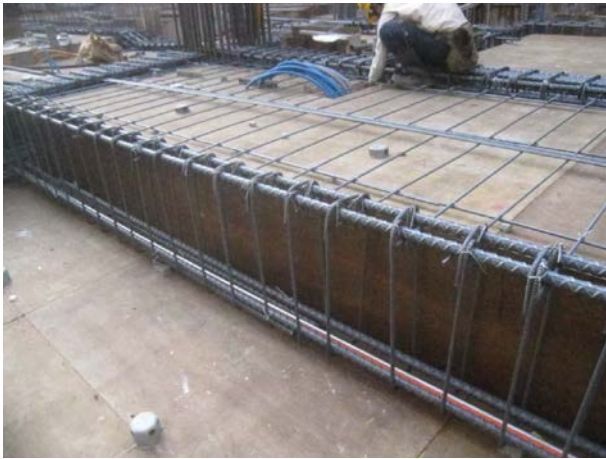
說明 13：版筋施工
