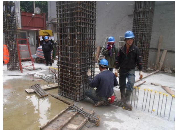
說明 4：柱鋼筋組立
