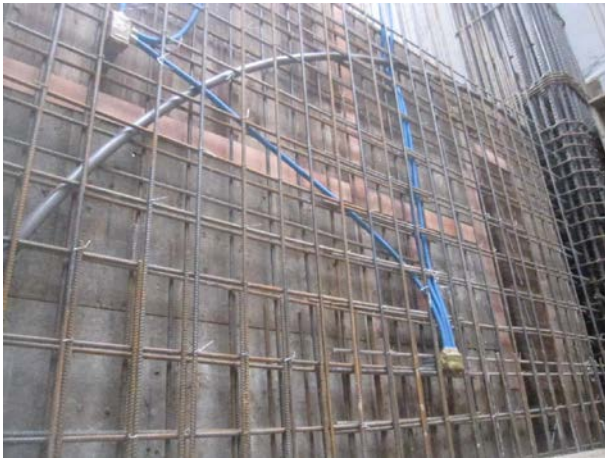
說明 19：牆鋼筋組立完成
