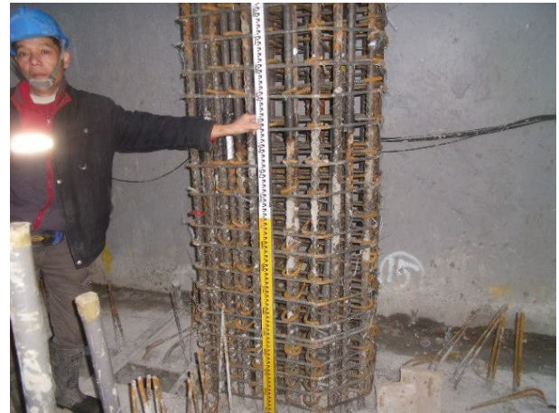
說明 10：柱鋼筋組立檢查
