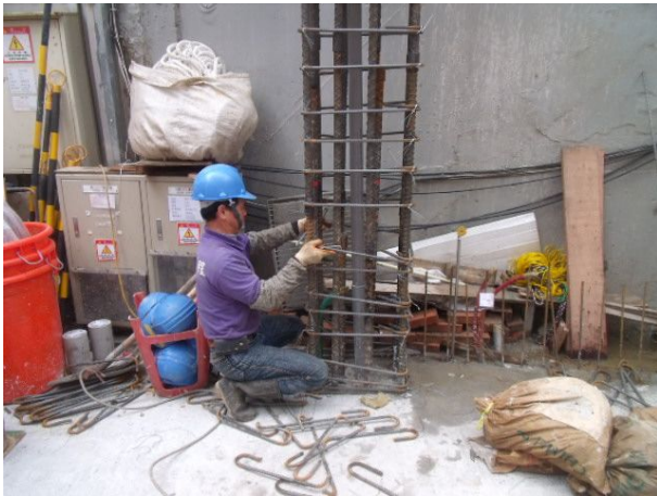
說明 3：柱鋼筋組立
