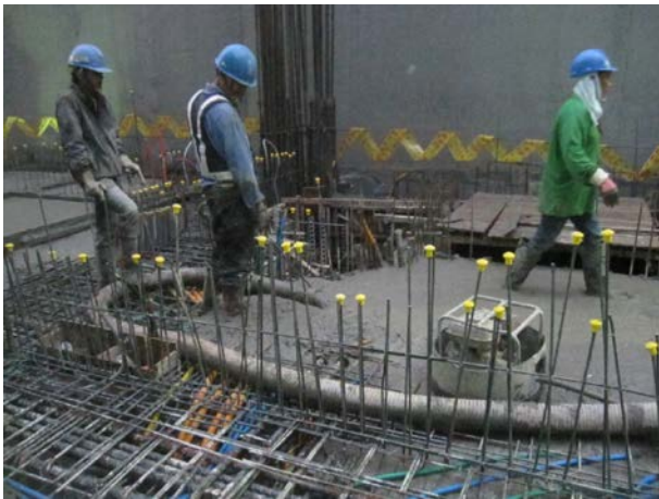
說明 9：混凝土澆置搗實
