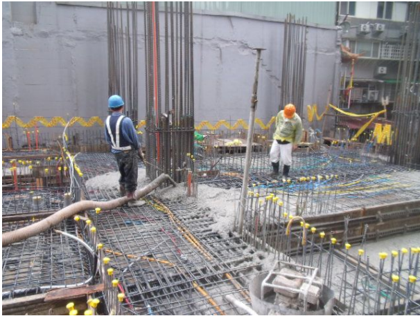
說明 7：混凝土澆置
