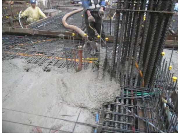
說明 8：混凝土澆置搗實
