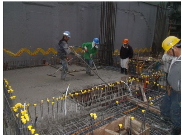
說明 10：混凝土澆置搗實
