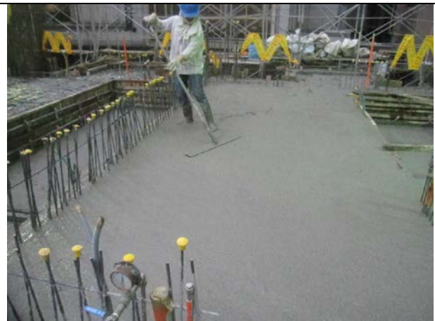
說明 12：混凝土推平
