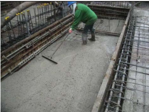
說明 11：混凝土推平
