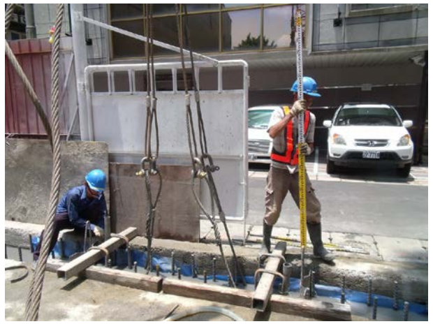
說明 14：鋼筋籠高程測定
