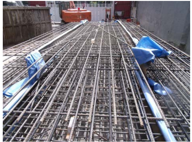
說明 2：鋼筋籠照片
