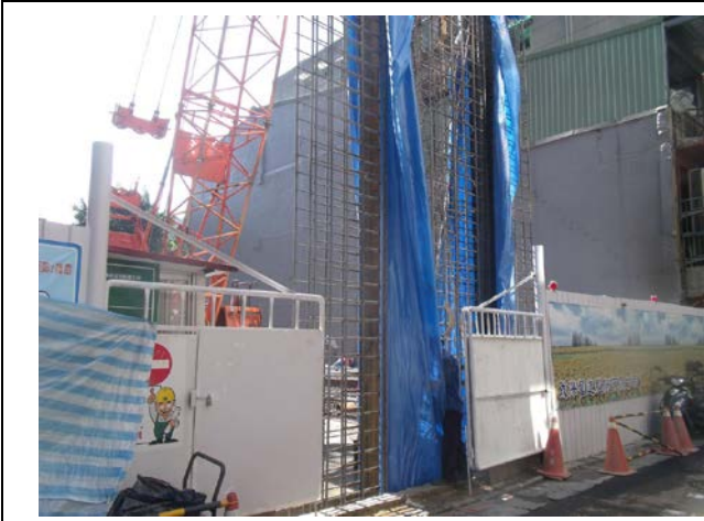
說明 13：鋼筋籠吊放
