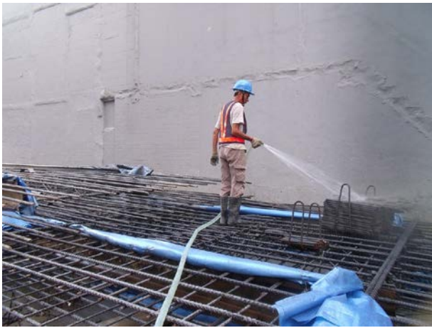
說明 9：鋼筋籠清洗
