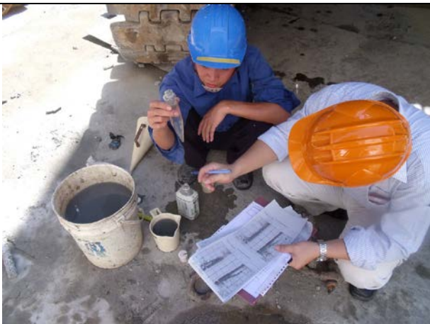
說明 11：開挖完成穩定液管理
