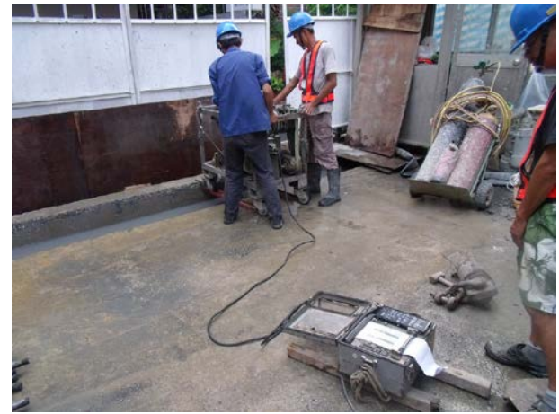
說明 10：開挖完成超音波檢測
