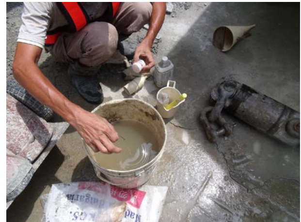
說明 4：開挖前穩定液管理
