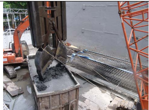
說明 6：開挖土方暫置
