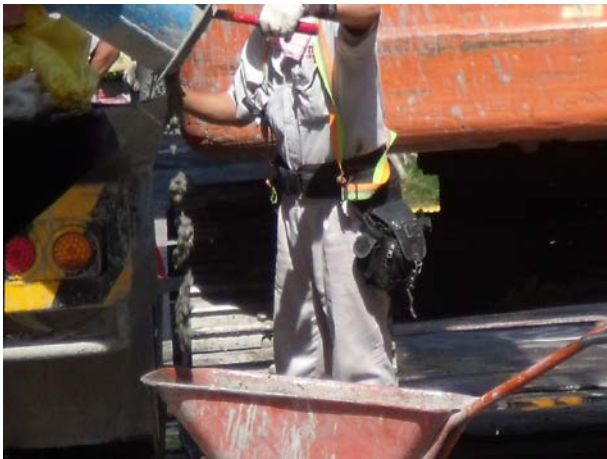
說明 15：混凝土取樣
