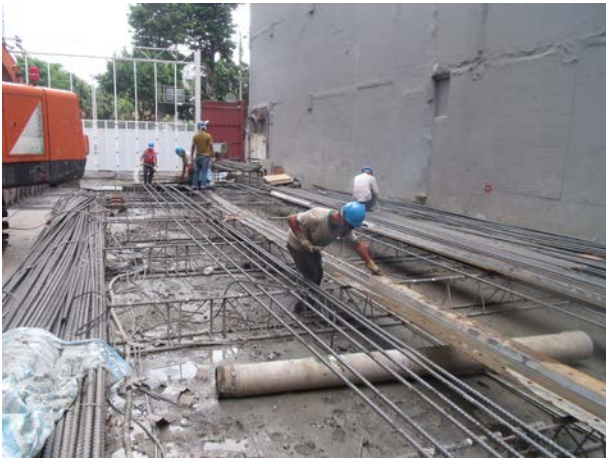
說明 1：鋼筋籠製作
