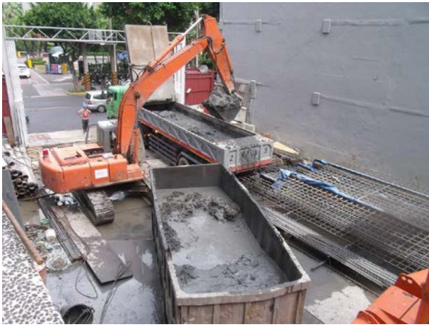
說明 7：開挖土方清運
