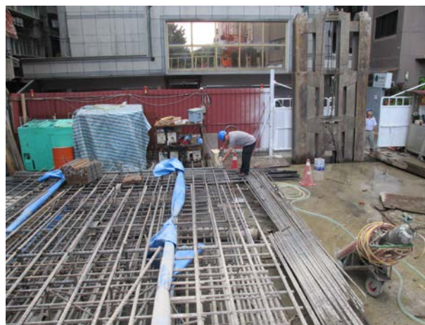
說明 2：鋼筋籠長度查驗
