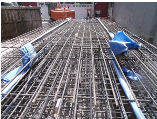
說明 1：鋼筋籠全觀
