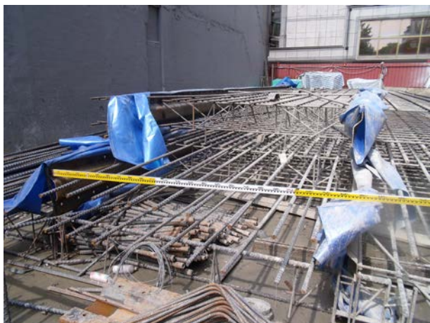
說明 3：鋼筋籠寬度查驗
