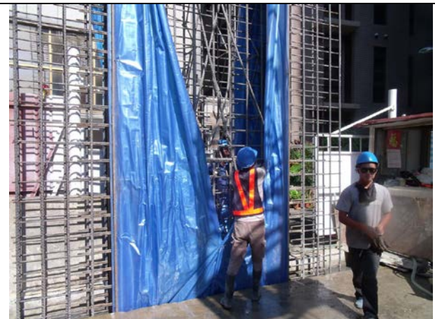
說明 12：鋼筋籠吊放
