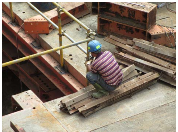
說明 8：構台欄杆安裝
