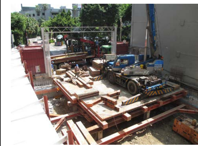
說明 7：支撐與構台架設
