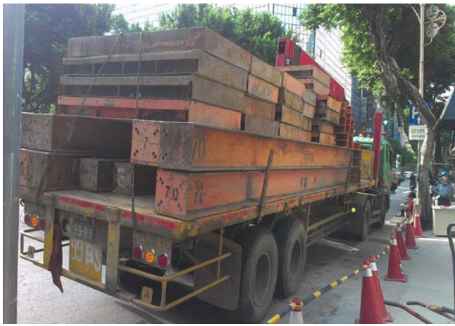
說明 7：H 型鋼進場
