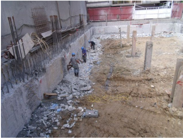
說明 1：圍令三角架安裝
