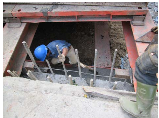
說明 10：圍令混凝土填縫
