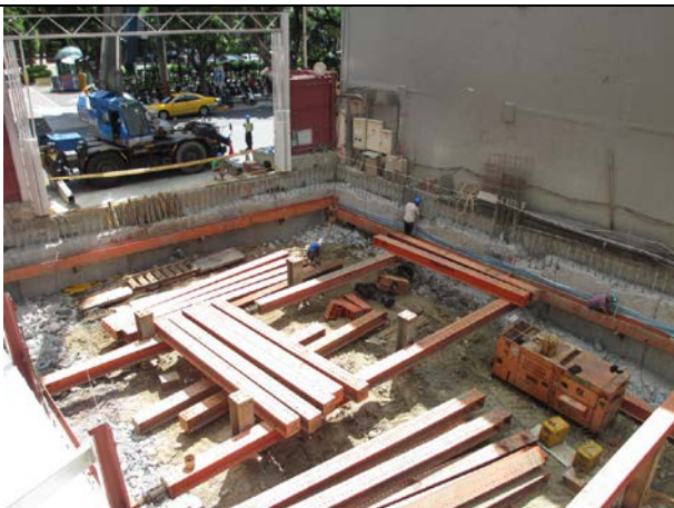
說明 5：支撐架設
