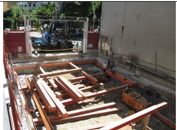
說明 6：支撐架設
