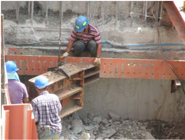
說明 13：斜撐安裝
