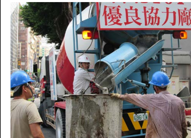
說明 9：圍令混凝土填縫
