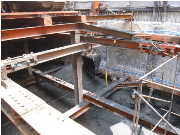
說明 1：土方開挖、運棄
