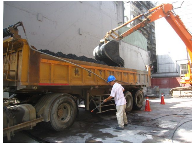
說明 8：土方開挖、運棄
