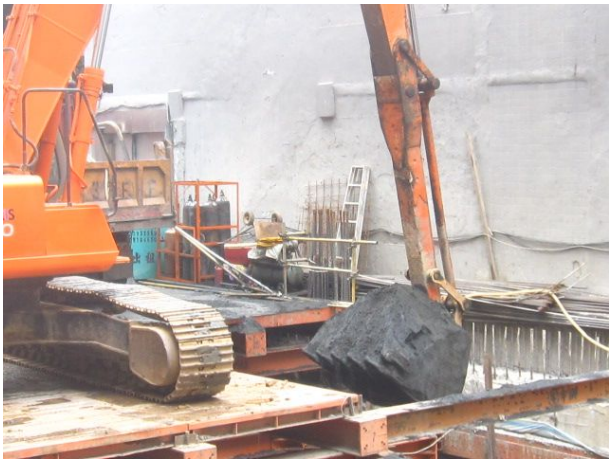
說明 3：土方開挖、運棄
