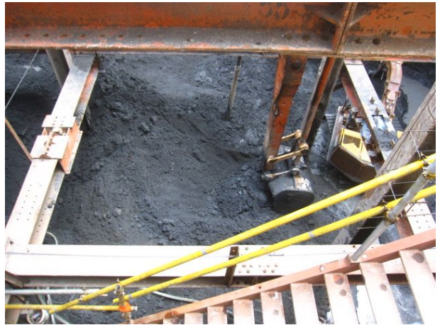
說明 2：土方開挖、運棄
