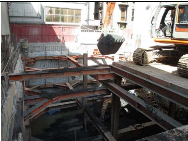
說明 5：土方開挖、運棄
