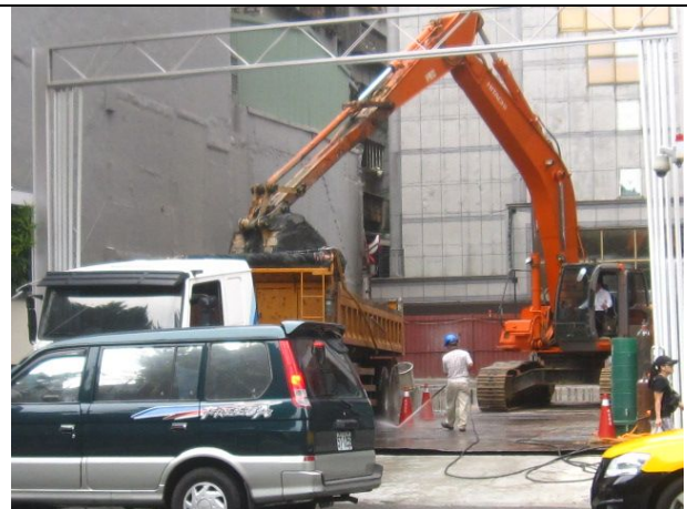
說明 6：土方開挖、運棄
