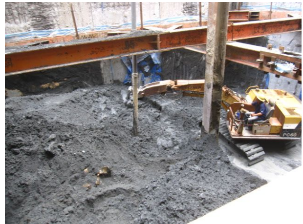
說明 4：土方開挖、運棄
